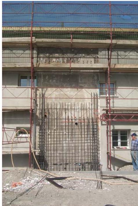
Figure A9 - Murs de refend en béton armé
